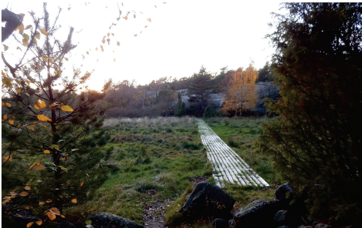
Figur 7 Kavlelagt fuktig parti på sti, Randholmen. Foto: Aase Richter
