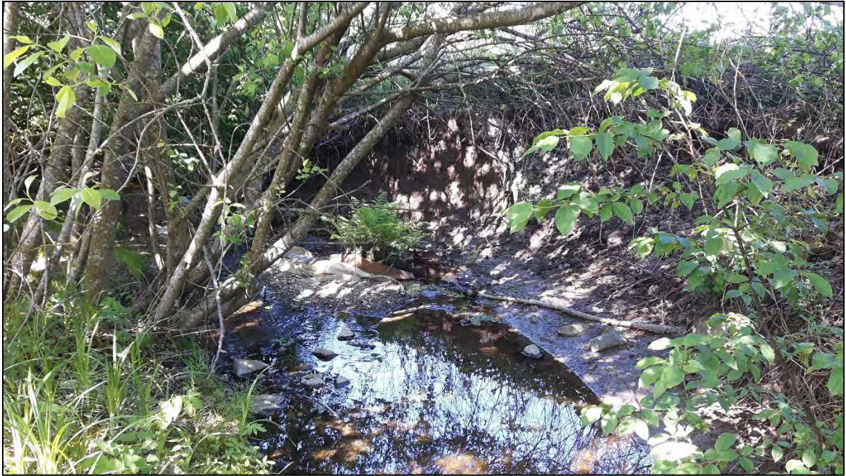
Fig. 10. Her graver bekken og må steinsettes. Gammel presenning i bekkeløpet må fjernes.
