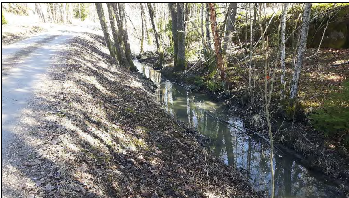
Fig. 9. Bekken nederst mot kulvert/rør under veg (her ble det observert gytefisk høsten 2017).
