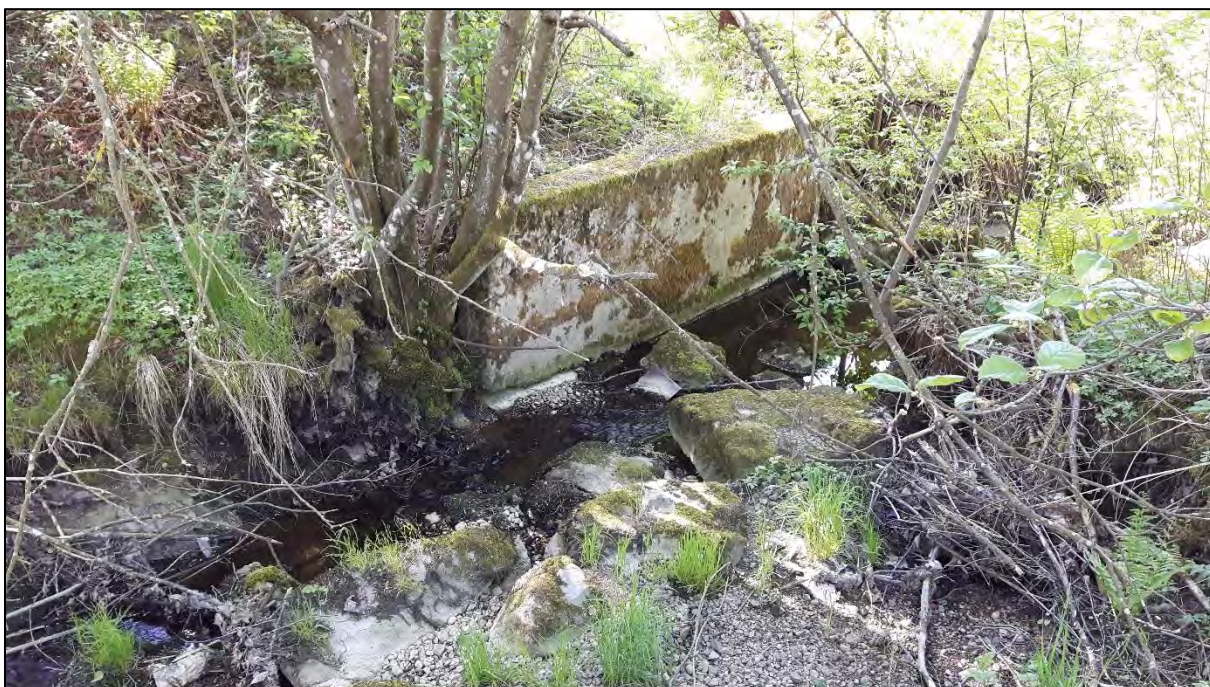
Fig. 19. Betongmur mot erosjon/utglidning like nedenfor bolighuset rett på oversiden av Fv. 116.
