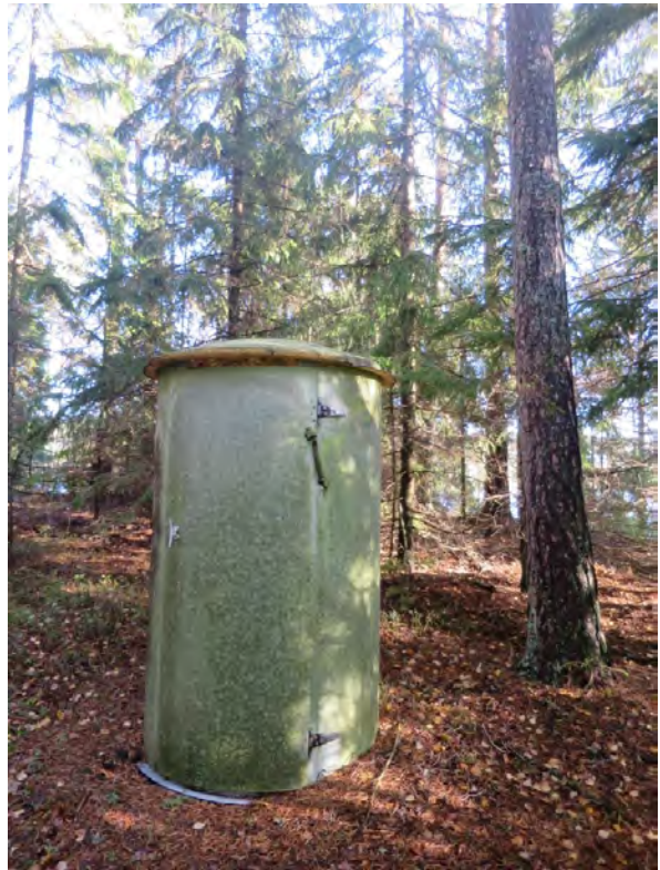
Det er plassert ut to toaletter på øya som er mye brukt som friluftsområde. Foto: Terje Blindheim
