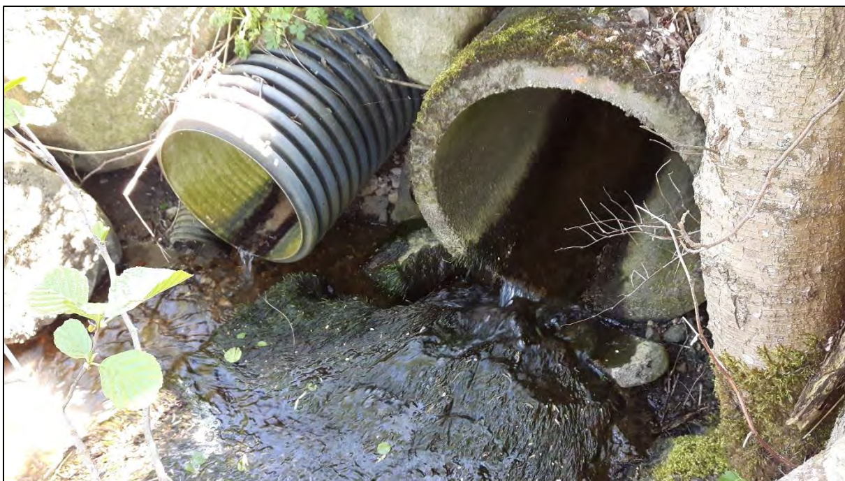
Fig. 14. Bekken lagt i rør nedenfor Fv. 116.
