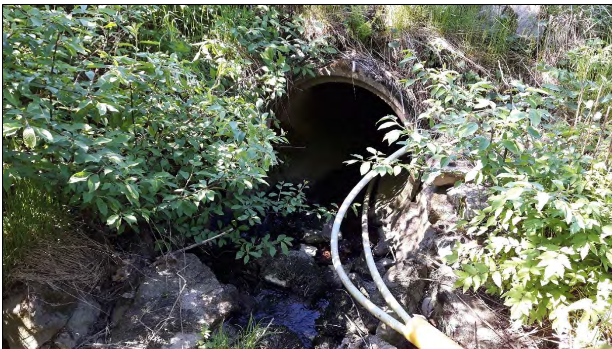
Fig. 22. Kulvert under Fv. 116 (nedre bekkelukking).
