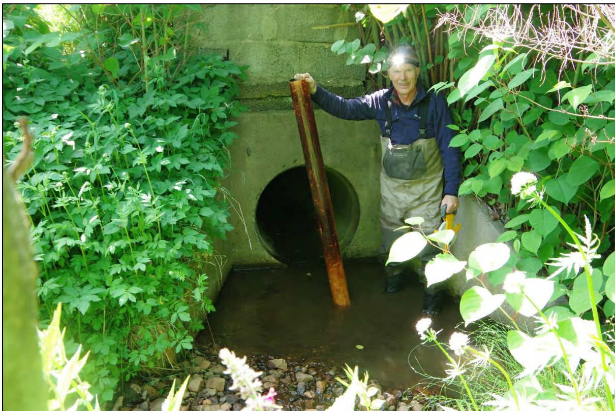
Fig. 8. Undertegnede ved innløpet til kulvert nr. 2, etter å ha krabbet gjennom røret for inspeksjon. Plastrøret på bildet satt kilt fast inne i kulverten og ble fjernet. (Foto: Amund Dahle)
