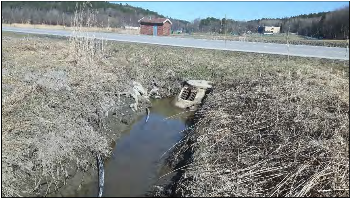
Fig. 5. Bekkelukking øverst ved Enhusveien (Kråkerøy ungdomsskole i bakgrunnen)
