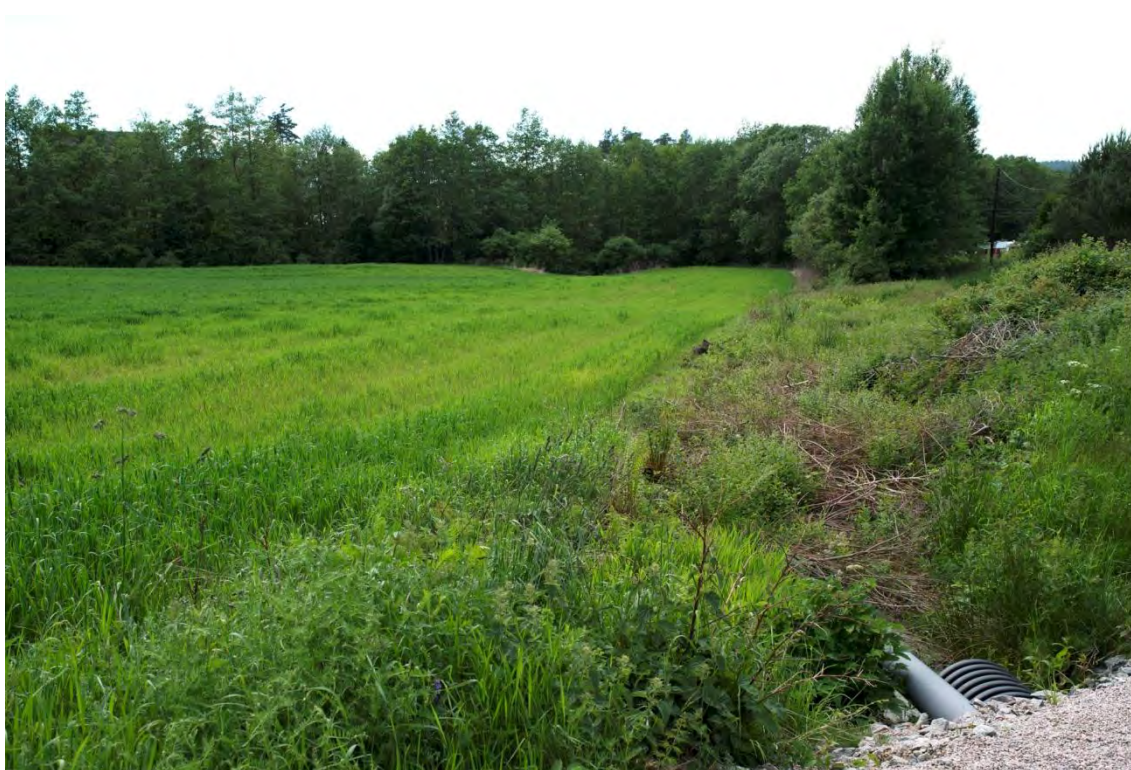
Figur 8 - Trevegetasjon mangler langs det nordøstre bekkeløpet
