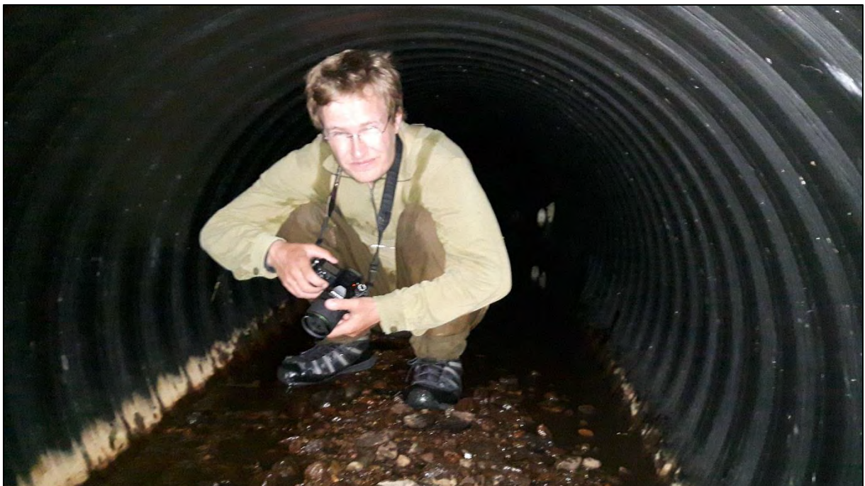
Fig. 6. Amund Dahle ca. 70 meter inne i kulvert nr. 1. (Foto: Leif R. Karlsen).
