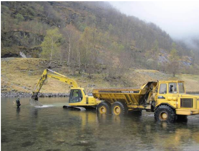
Figur 3 Grusutlegging ved Skaim 2010
