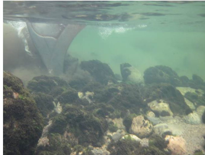
Figur 2 Harvingen sett under vann. Gravemaskinen mistet tenner i skuffen grunnet det harde armeringslaget.
