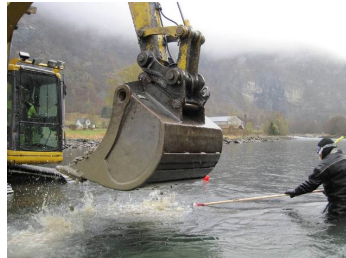
Figur 4 Dykker har utvalgt et egnet sted for grusutlegget og anviser gravemaskinfører
