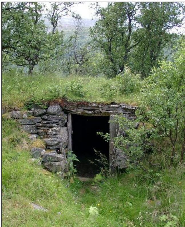
Figur 19. På Risgjerdessætra stå dette rundt 300 år gamle jordfjøsset. På tross av oppslag av bjørk fremstår det i god stand. Også innredningen er bevart.
