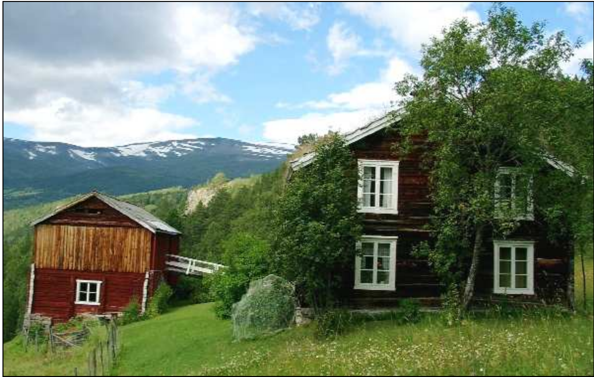
Figur 28. De mange laftede, upanelte bygningene preger hele området mellom Aalbu og Vang. Husmannsplassen Aalbusbakken er bare et av mange steder her hvor det tradisjonelle bygningsmiljøet er tatt vare på.
