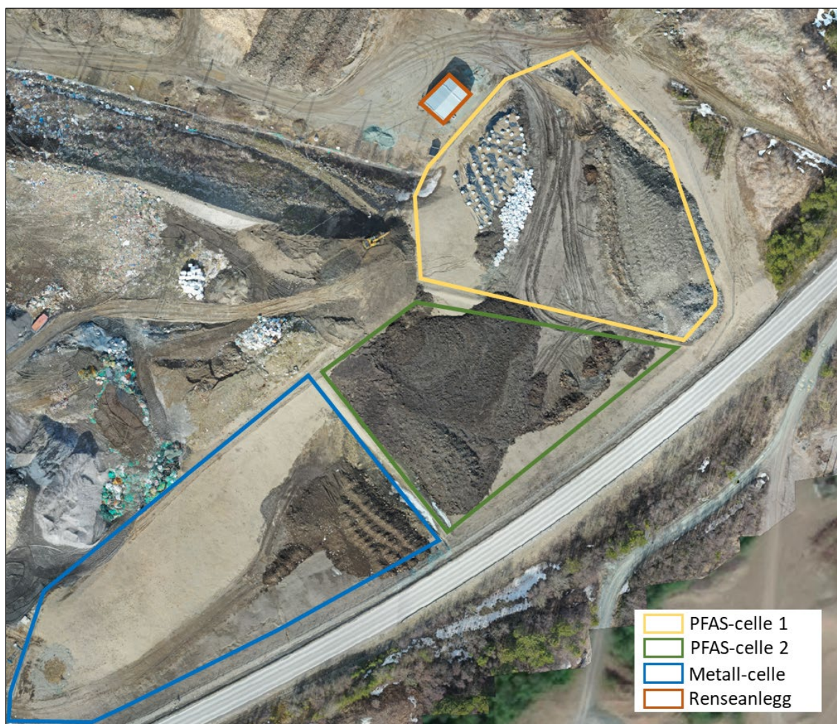
Figur 1 Dronebilde av Deponicelle 2, trinn 3 på Stormoen deponi. Cellen er delt opp i tre spesialceller, hvorav det i de nederste 2 cellene lagres PFAS-forurensete masser. PFAS-celle 2 ble tatt i bruk i april 2021.
