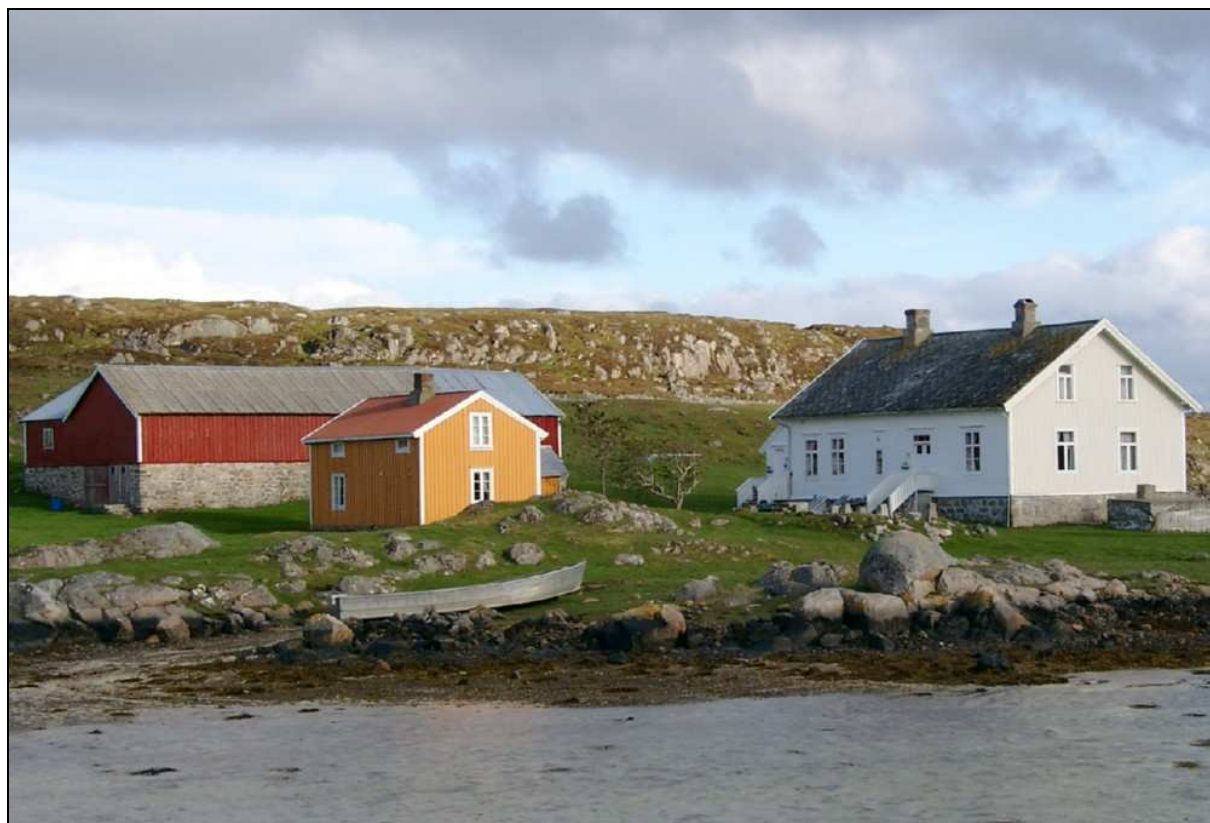
Figur 9. Den gamle prestegården på Rottingen er fullstendig restaurert og brukes i dag som feriehus kombinert med utleie av leiligheter og drengestua. Kulturmarka holdes i hevd med beitende sau.
