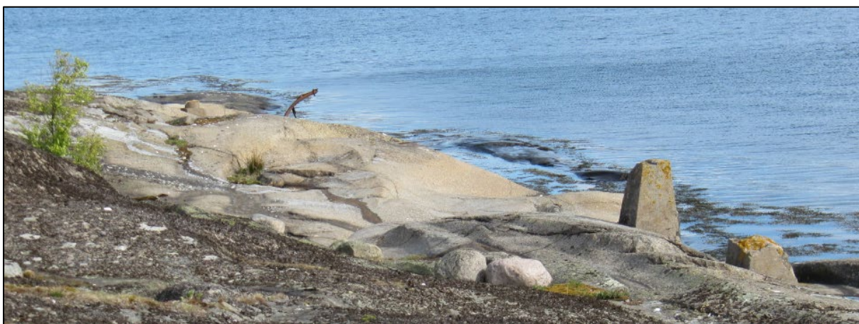
Figur 35: Til høyre to av sementsoklene. Restene av den tredje, der «1904» er risset inn i støpen, vises til venstre mellom busken og den oppstikkende jernsaken ID 271097-0.
