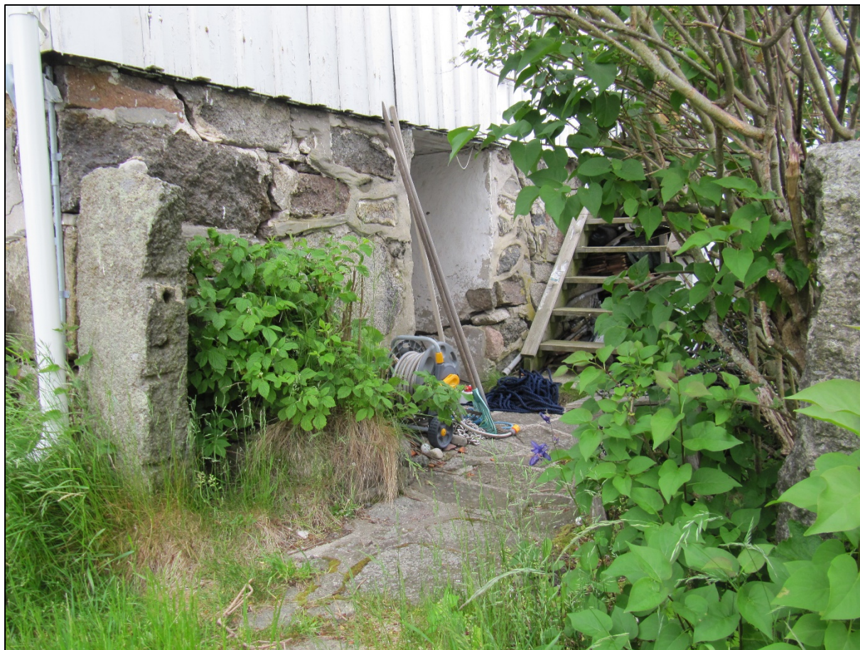
Figur 90: Sandø. Nordvesthjørnet av bygning 9 ID 271300-0. Huset har store likheter med nabohuset i nord bygning 8, og kan være av samme alder.
