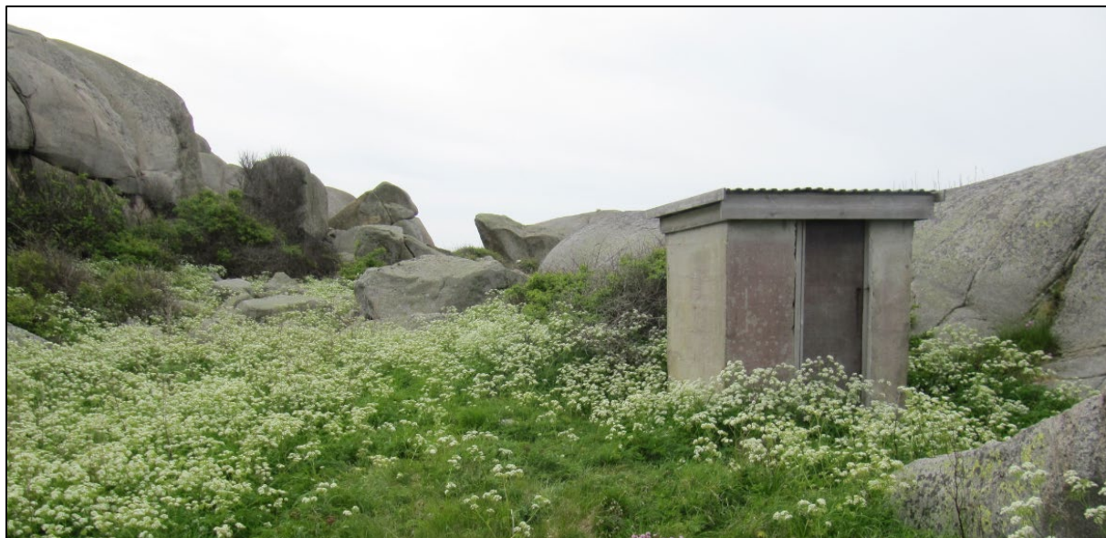
Figur 106: Uleholmen. Toalettfasilitetene på øya. Sett fra nord.
