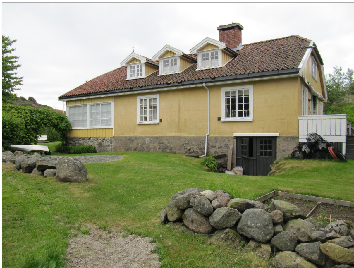
Figur 68: Vasskalven. Den tidligere låven, bygning 11 ID 271250-0, sett fra nordnordvest.
