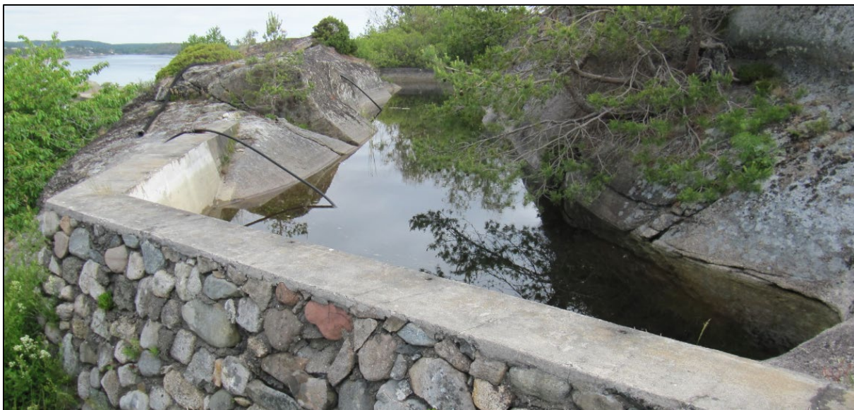
Figur 65: Vasskalven. Dam ID 271258-0 fra 1930-tallet tilknyttet bygning 3.
