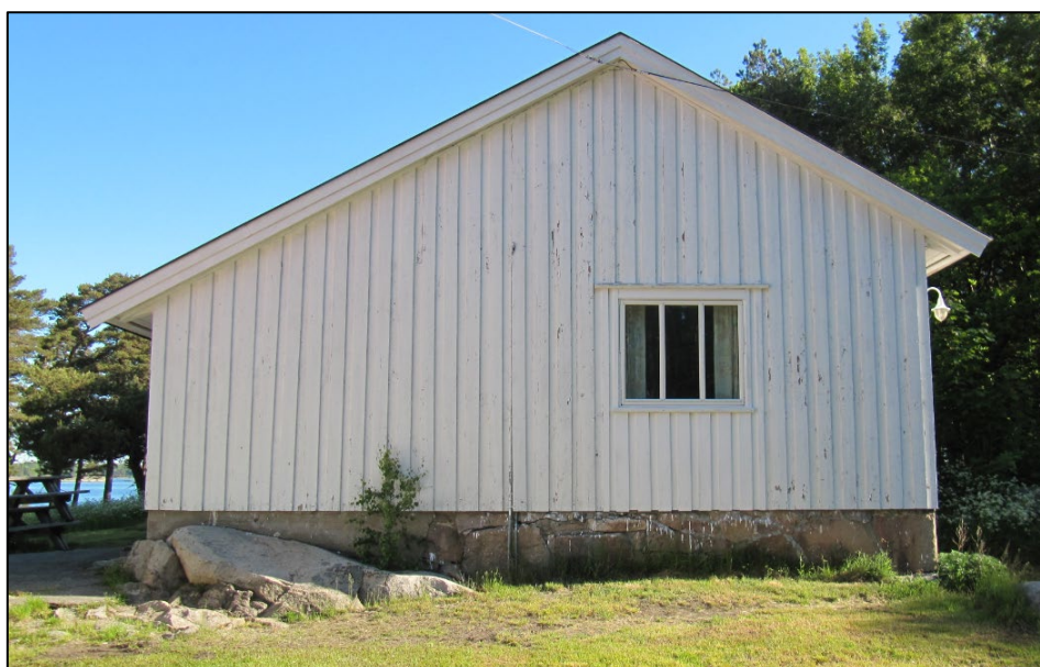
Figur 131: Hui. Bygning 47, ID 271405-2 sett fra sør.
