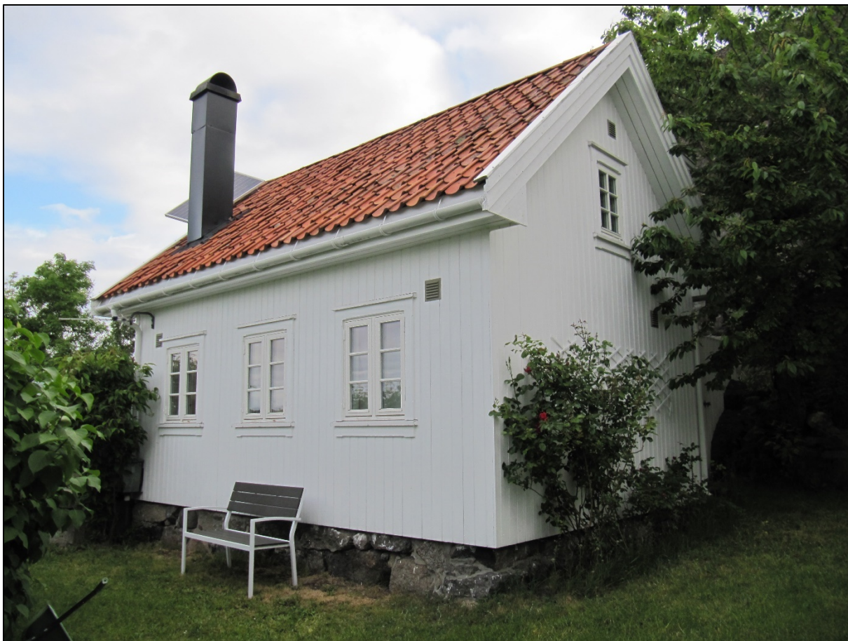
Figur 73: Vasskalven. Bygning 20B ID 271239-0, trolig uthus til bygning 20, sett fra sørvest.
