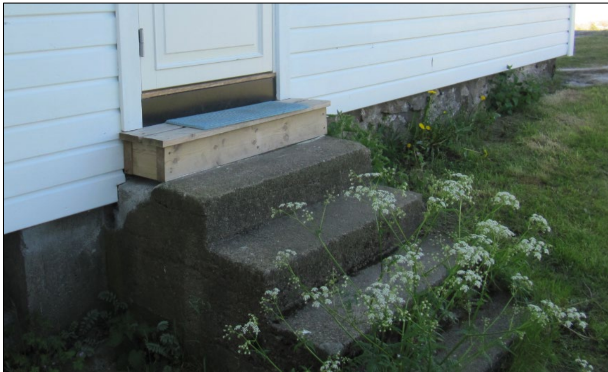
Figur 137: Hui. Deler av grunnmuren til bygning 53, ID 271407-0 sett fra sørøst
