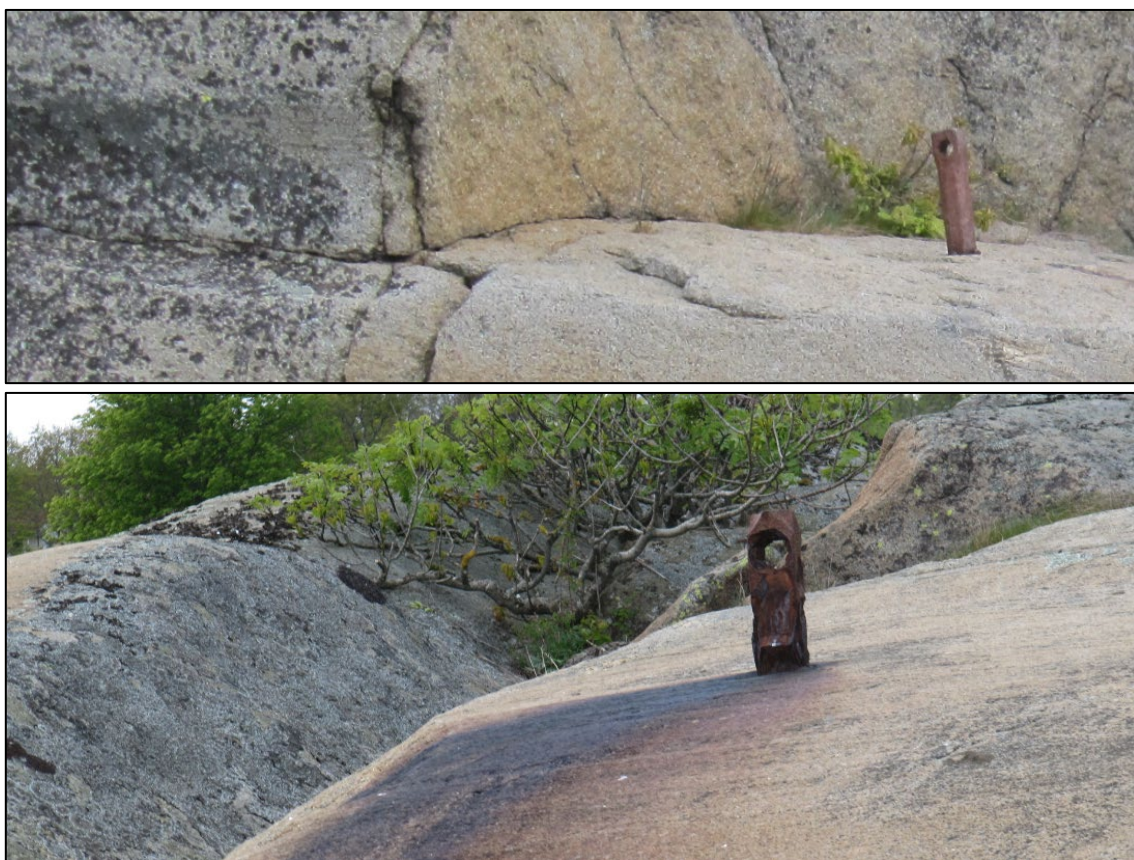
Figur 60: Navnløs holme under bnr. 2 av Søndre Holme. Kraftige jern (øyebolter) som kan ha vært til akterfortøyning av større skuter, ID 271224-0.
