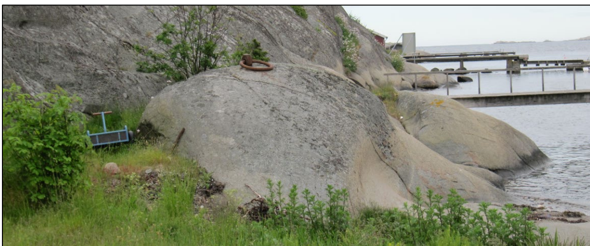
Figur 92: Drøye 40 m sørsørvest for bygning 9 er det satt ned en svært kraftig fortøyningsring i svaberget i strandkanten. Godt egnet for en større båt eller et skip ID 271303-0.
