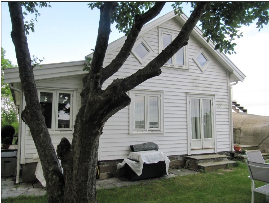
Figur 74: Vasskalven. Bygning 30 ID 271236-0 sett fra nordnordøst. Den har trolig vært for en strandsitter med livsgrunnlaget knyttet til sjøen.
