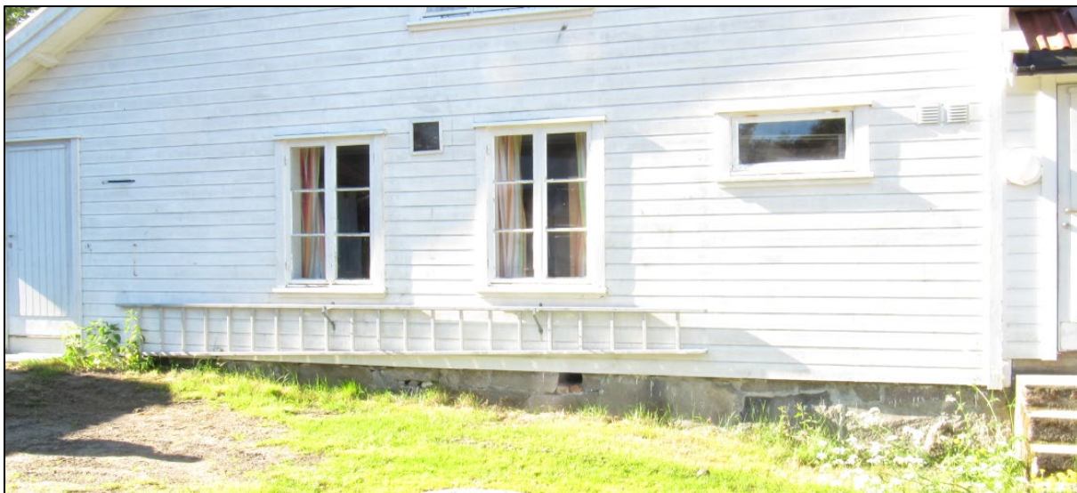
Figur 135: Hui. Bygning 51, ID 271406-0 sett fra vest. Det er få steder det i dag lar seg gjøre å få et godt inntrykk av den gamle grunnmuren.
