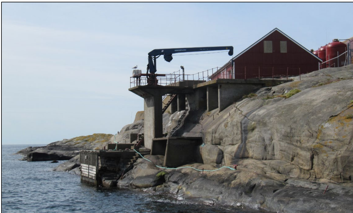
Figur 105: Tristein. Kaia som brukes til lasting og lossing. Sett fra nord.
