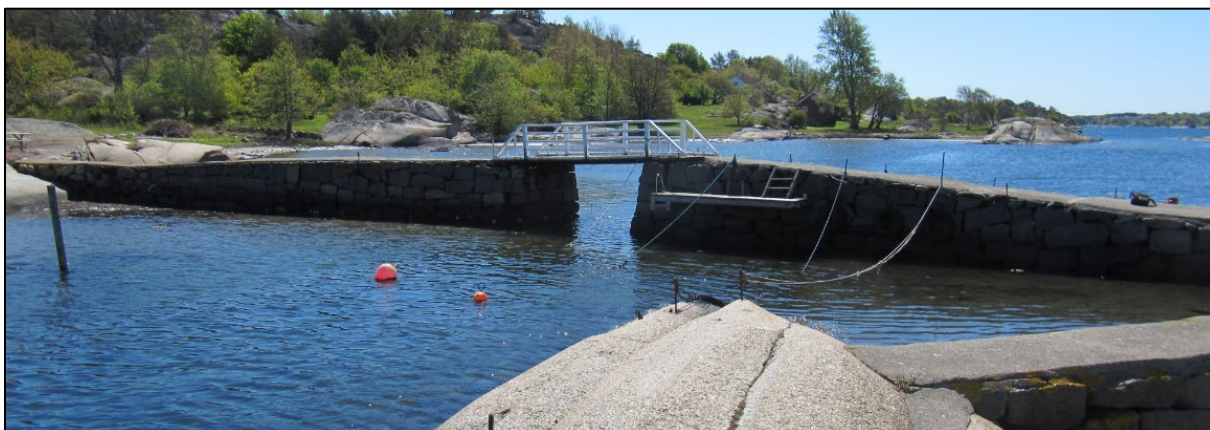
Figur 77: Vasskalven. Deler av brygge- og moloanlegget vest på øya, ID 271290-0. Steinene er til dels minert ut på skjærene anlegget er tilknyttet, og delvis fra svaberg inne på øya.
