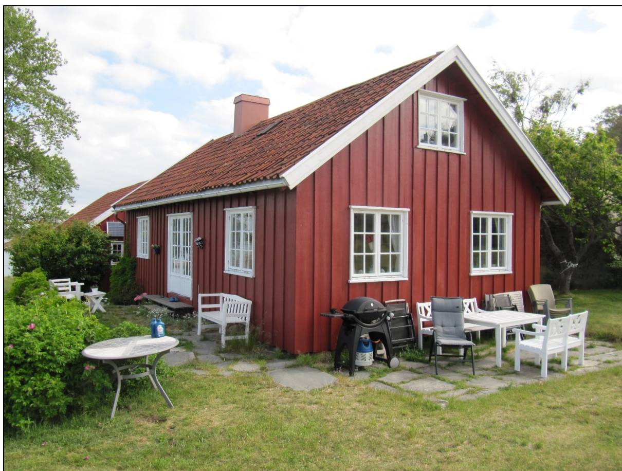
Figur 67: Vasskalven. Bygning 5, ID 271255-0 sett fra sørvest. I bakgrunnen bygning 6.
