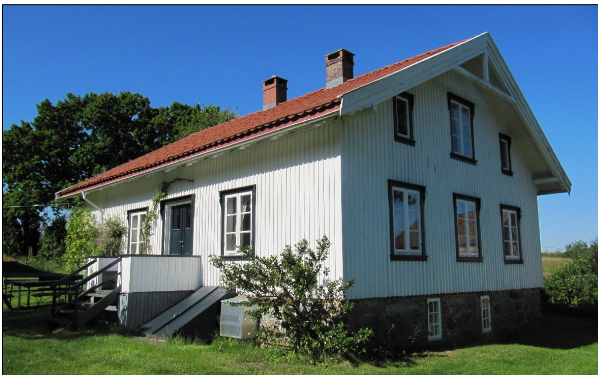
Figur 22: Bygning 11, hovedhuset ID 271086-1. Sett fra nordøst.
