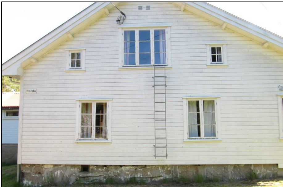
Figur 132: Hui. Bygning 46 ID 271405-1 sett fra sør.
