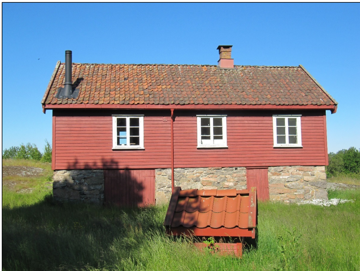
Figur 24: Bygning 12, trolig den eldre driftsbygningen, ID 271086-4. Sett fra øst.
