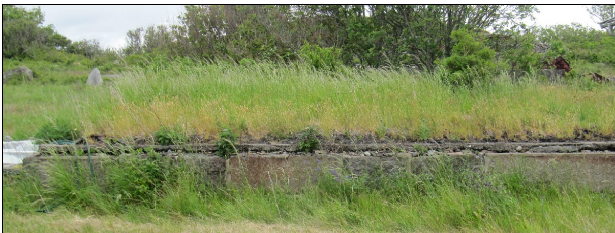
Figur 95: Sandø. Bildet viser hva som må være den eldste grunnmuren ID 271308-0 i en driftsbygning som gjennom årene er blitt gjenbrukt. Sett fra vest.
