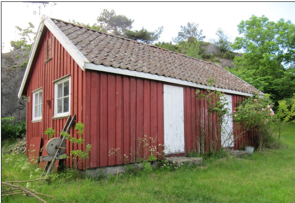
Figur 76: Vasskalven. Bygning 31B ID 271234-0 sett fra nordvest. Den var trolig uthus til bygning 31.
