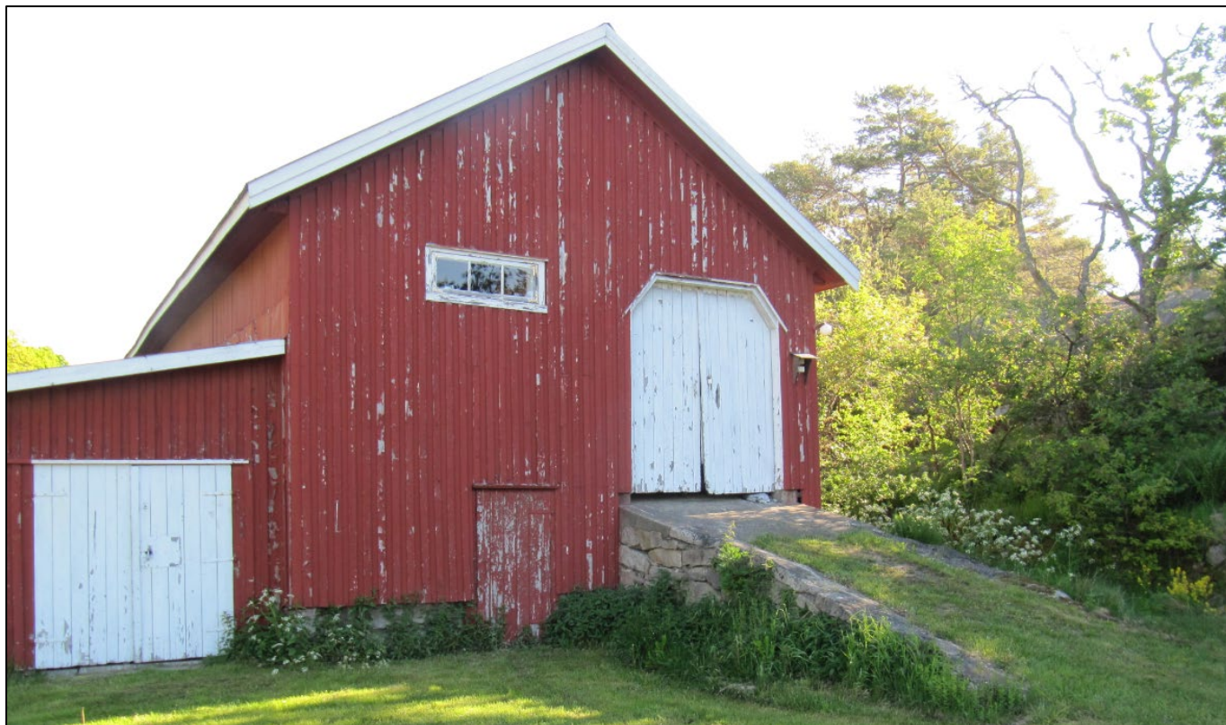
Figur 130: Hui. Bygning 30, ID 271400-0 sett fra sørvest.
