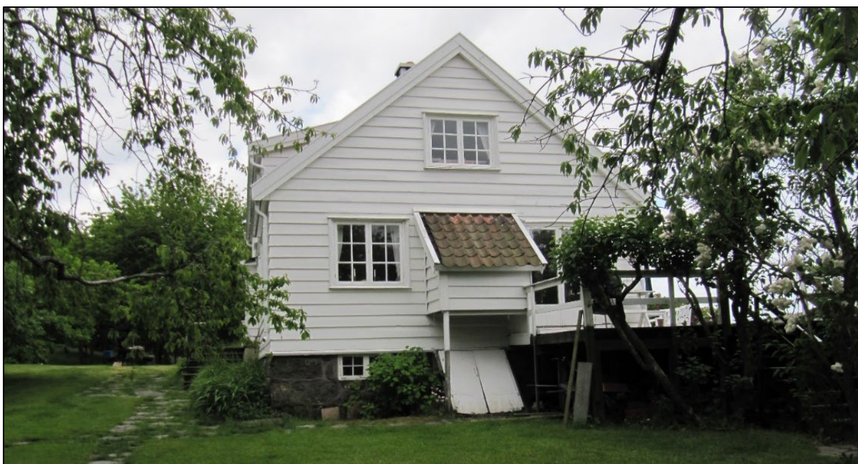
Figur 66: Vasskalven. Bygning 3, ID 271254-0 sett fra nord.
