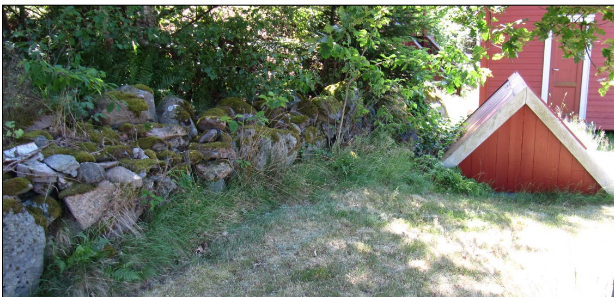
Figur 21: Steingard sørover fra gårdstunet mot Søndrebukta, samt gårdens brønnhus. Denne type steingard er lavere og smalere enn de som skiller innmark og beite, og dens primære formål var å tette igjen åpninger i og mellom svabergene rundt tunet ID 271450-0.
