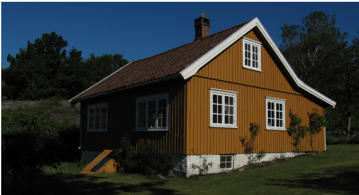
Figur 29: Det eldre bolighuset sett fra sørøst, ID 271084-5.
