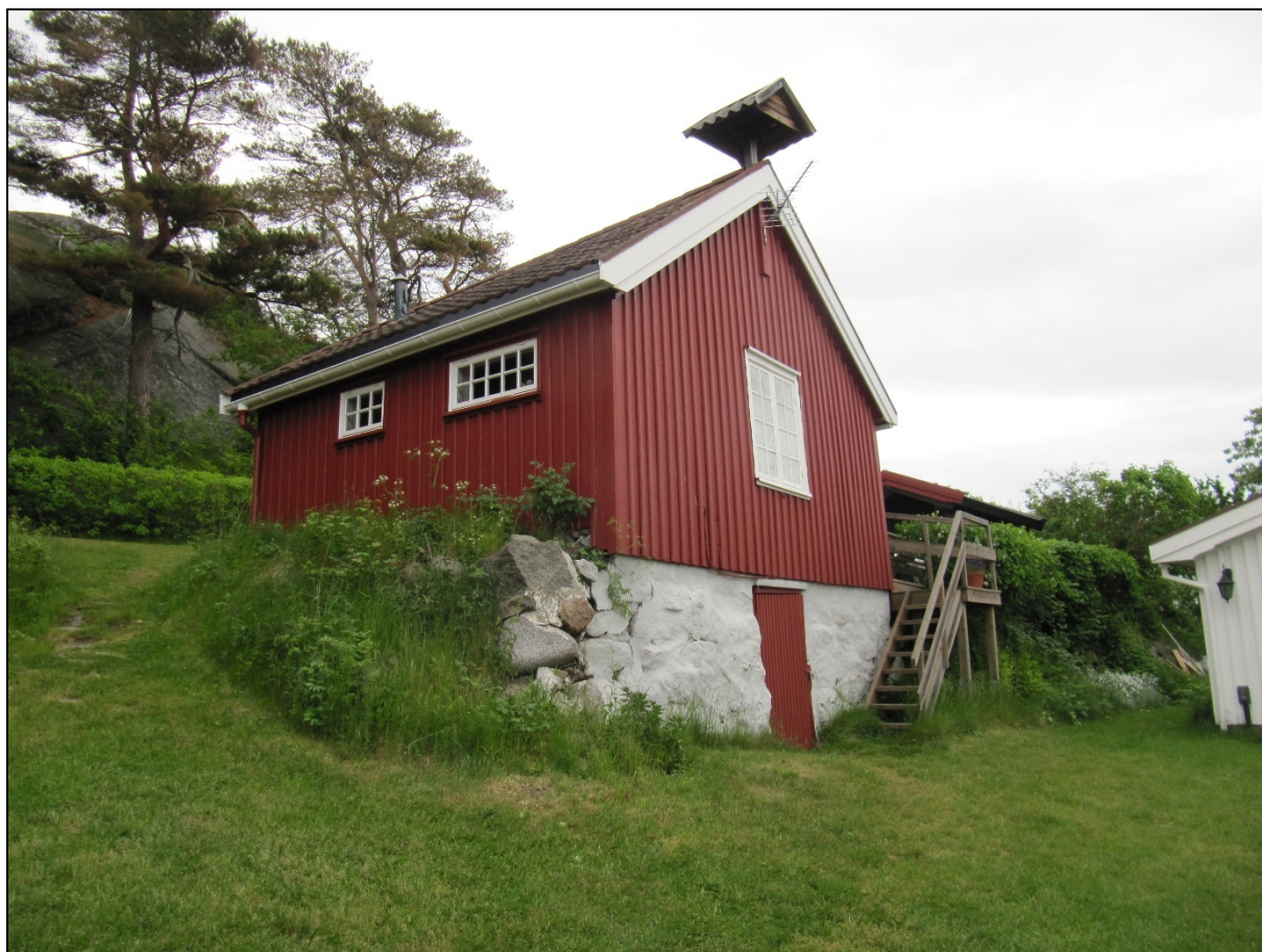
Figur 89: Sandø. Uthuset bak bygning 6C ID 271298-0, (her betgnet 6B). Også dette er yngre enn 1812.
