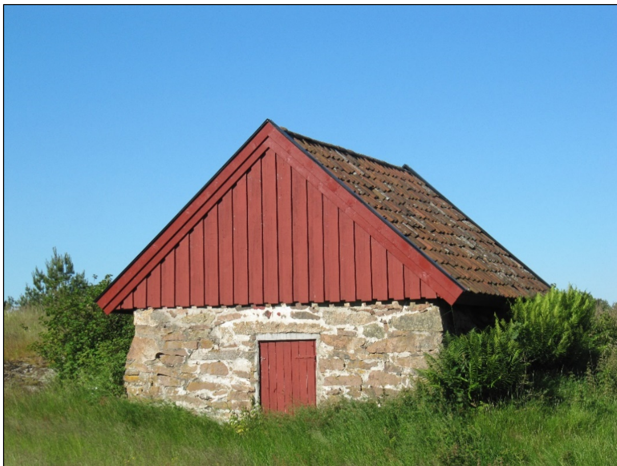
Figur 25 Bygning 12B, trolig en tidligere kjeller ID 271086-3. Sett fra østnordøst.
