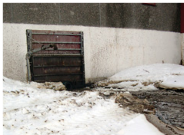
Prefabrikerte gjødselporter trenger jevnlig tilsyn og vedlikehold!
