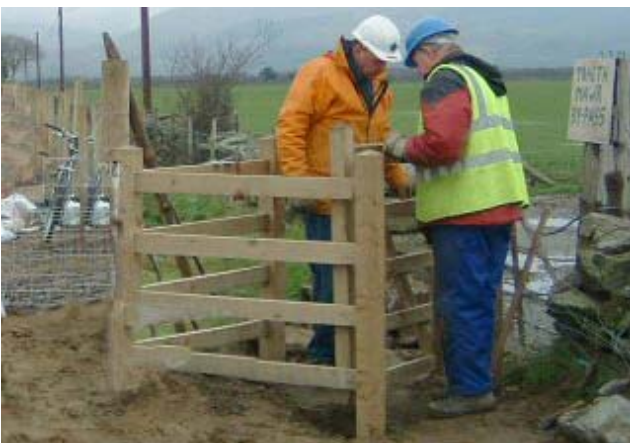
Montering av sjølvlukkande grind.
